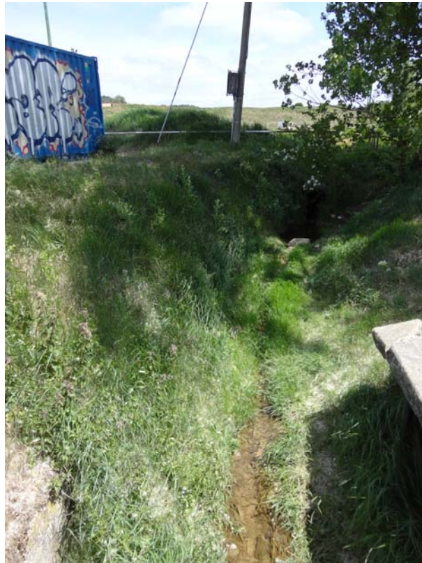
Foto 1.2.- Vista detallada del encauzamiento superficial existente, que será objeto de una limpieza y revestimiento.
